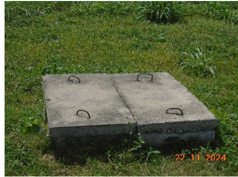
ภาพที่ 2.2 บ่อพักน้ำเสีย (Manhole)
