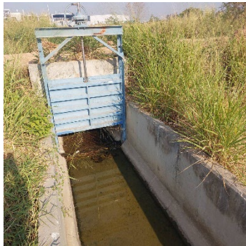
ภาพที่ 2.15 ประตูปะบายน้ำและอาคารสลายพลังงานเพื่อลดความเร็วและแรงของน้ำ
